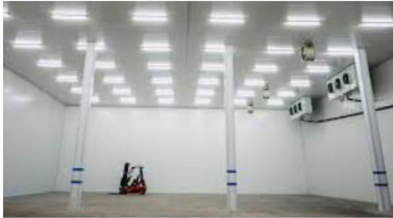
FIGURA 2.- FUENTE: WEB-CÁMARA DE CONSERVACION
