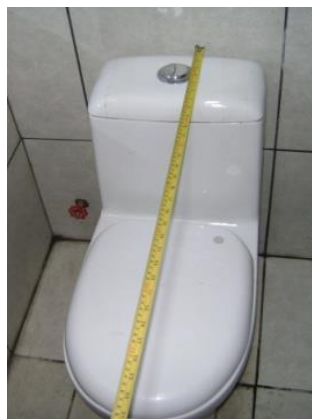
Inodoro de una sola pieza (tanque y asiento) Con batería de doble descarga regulable
