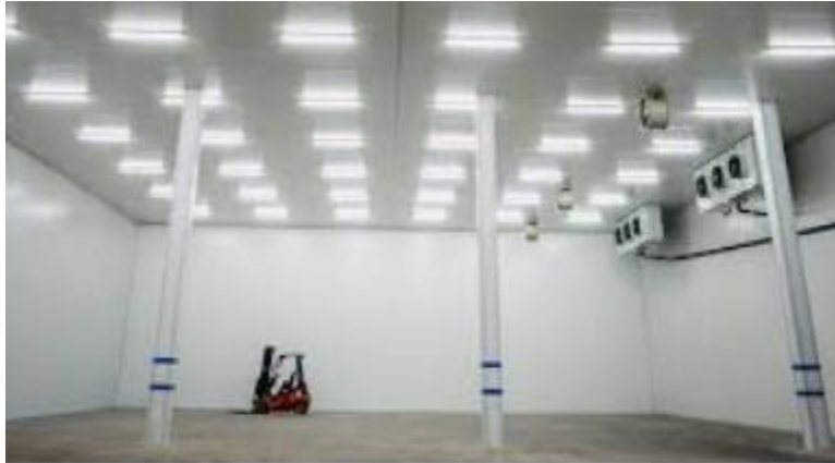
FIGURA 3.- CAMARA DE CONSERVACION
