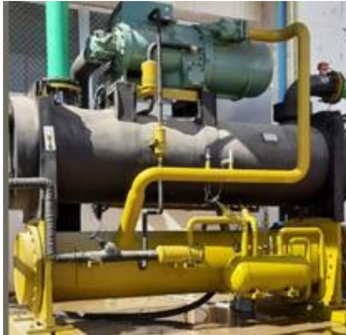
FIGURA 67.- FUENTE: WEB- SISTEMA DE FRIO (CHILLER).
