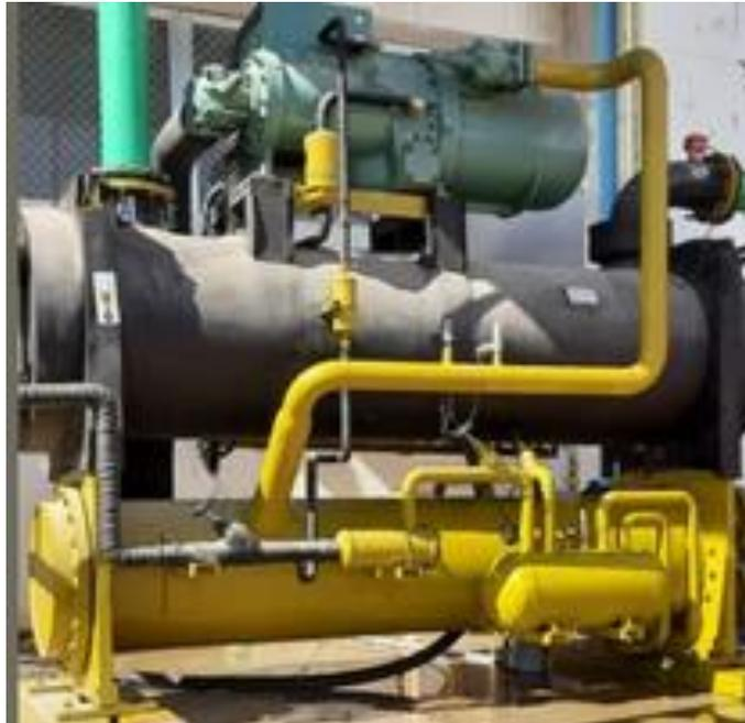
**FIGURA 67.- FUENTE: WEB- SISTEMA DE FRIO (CHILLER).**
